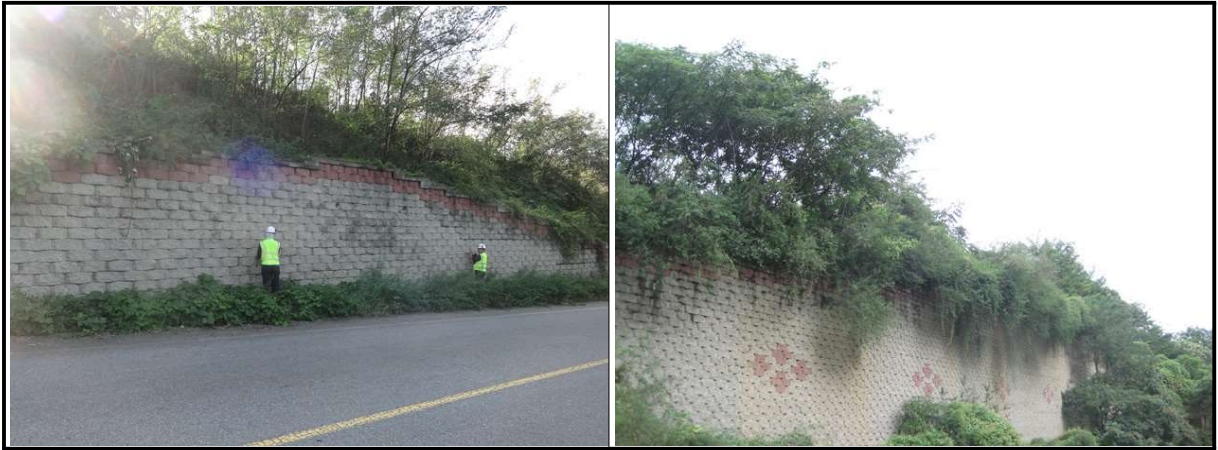
【그림 9.3.1】 전면부 전경(보강토옹벽)
