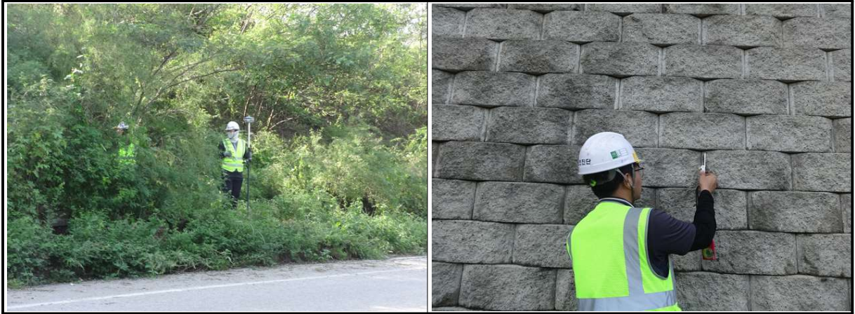
【그림 9.3.3】 측량작업 전경(보강토옹벽)
